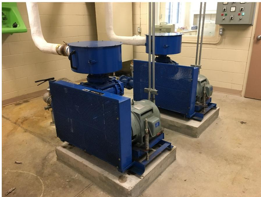
**Figure 3.4 : Surpresseurs d'air**
