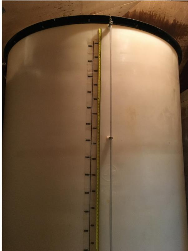
**Figure 3.6 : Réservoir d'entreposage du coagulant**
