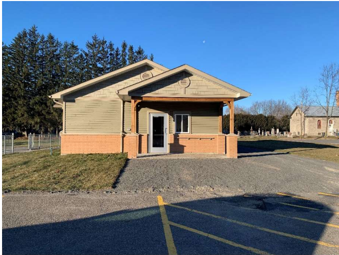
Construction du nouveau Chalet des Loisirs au parc Primevère
