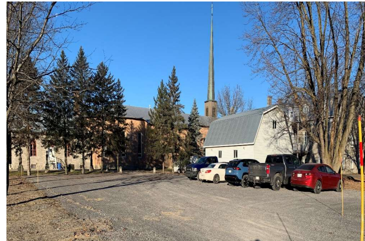
Début des travaux du nouveau stationnement pour le futur Centre multifonctionnel Gervaise Bélanger
